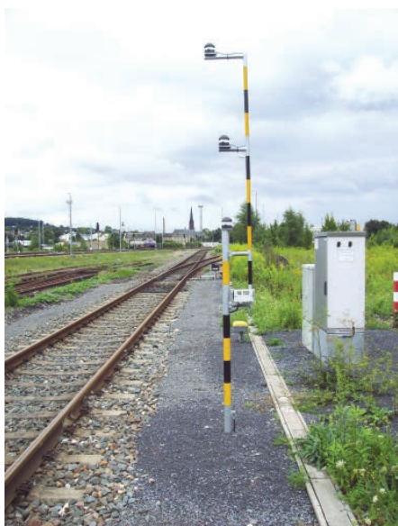
Abb. 1: Bedienstelle einer EOW mit Schlagtastern in drei Ebenen
